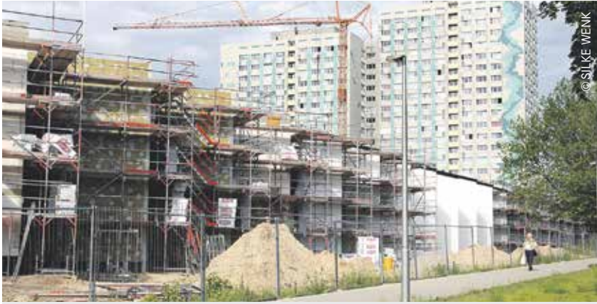
Nördlich der Gensinger Straße 103 entstehen 3 Mehrfamilienhäuser mit 223 Wohneinheiten.
