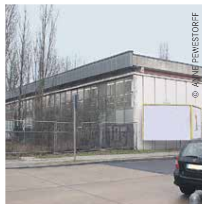
Die Lichtenberger Turnhalle in der Wollenberger Straße 1 konnte freigezogen werden.
