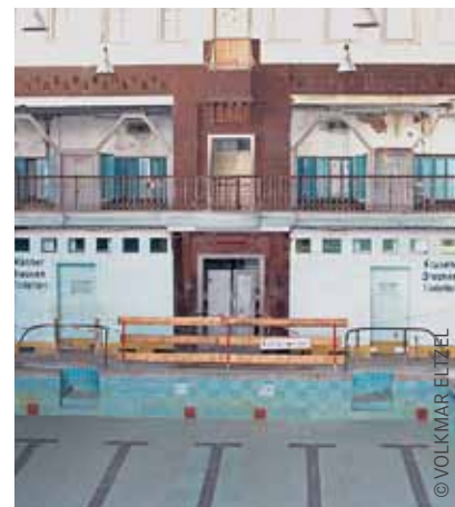
Das Schwimmbecken im Hubertusbad ist schon seit Jahren ohne Wasser.
