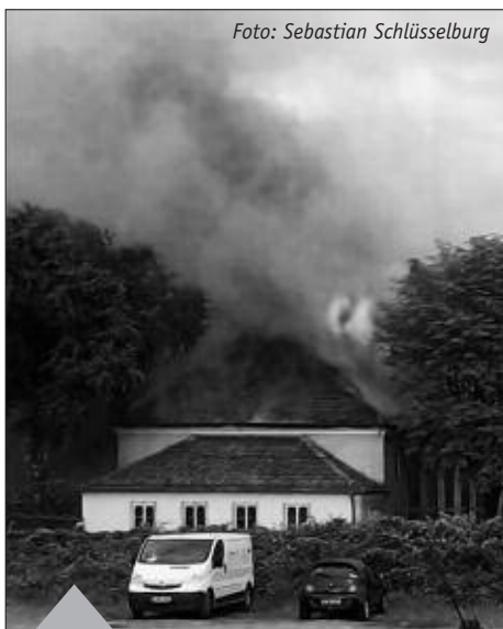
3. Juli 2013: Die Turnhalle des Hans-und-Hilde-Coppi-Gymnasiums am Römerweg steht in Flammen.
