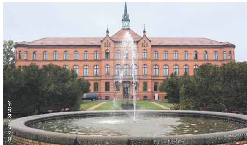
Das Verwaltungsgebäude des KEH in einem schönen Landschaftspark.
