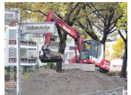
Die Rüdigerstraße wird seit September saniert.
