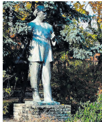
Das Hermann-Duncker-Denkmal muss dringend saniert werden.
