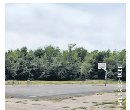
Auf der Sport- und Freizeitfläche an der Hauptstraße 9 wird eine Grundschule gebaut.
